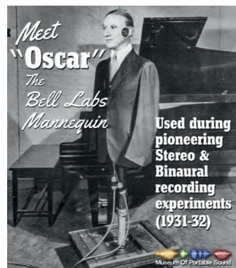
„Oscar“: Die Wachsfigur entstand in den 1930er-Jahren in den Bell Laboratories (USA) und wurde unter anderem für Aufnahmen mit einem Symphonieorchester eingesetzt.
